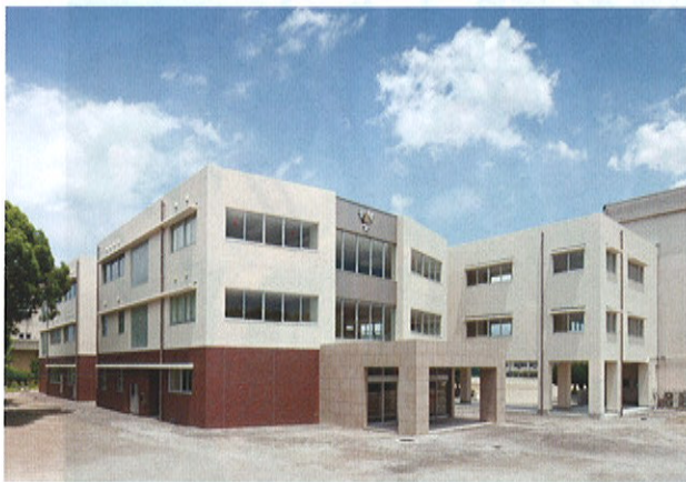
竣工した新管理棟
