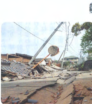
益城町 住宅街地割れ
